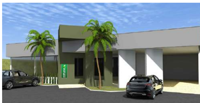
Ilustração prevista da fachada quando as obras estiverem terminadas
